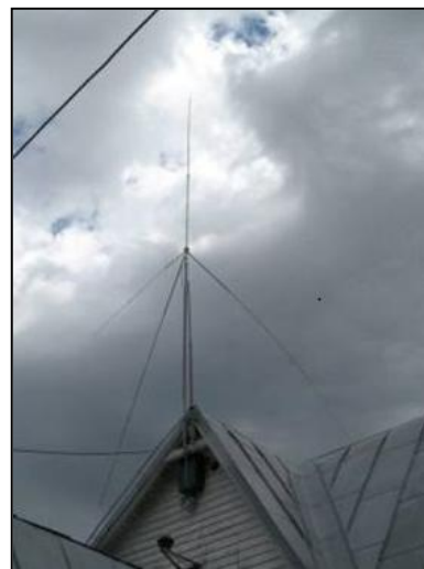
Fig. 2. Instalație de protecție împotriva orajelor
