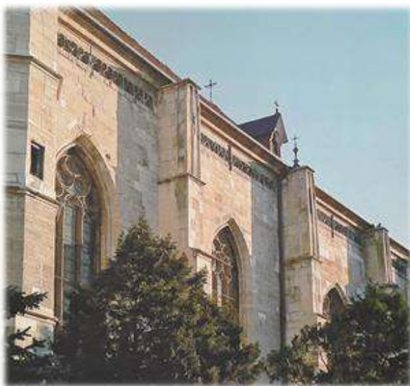
Contraforţi pe peretele nordic
